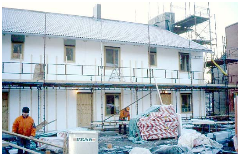
Bild 2.5 Lindåshusen under byggnation.
