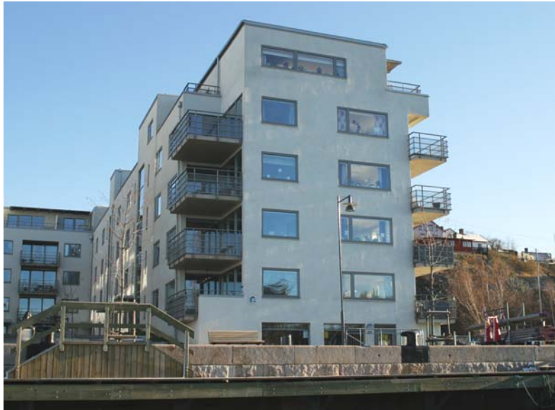
Bild 5.9 Motgjuten EPS-cellplast som putsats med ett tjockputssystem.
