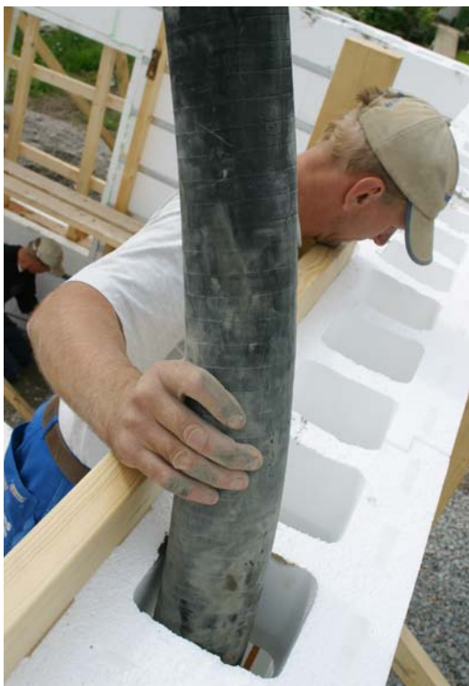
BILD 5.20 Form-element av EPS-cellplast som kan igjutas med betong.
