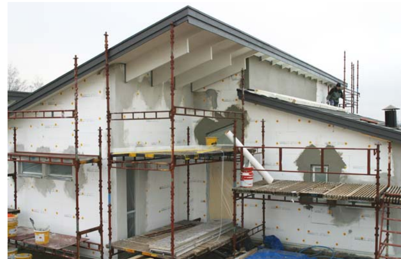
BILD 5.13 EPS-cellplast som värmeisolering och vindskydd i ytterväggar innebär möjligheter till optimala väggkonstruktioner ur energisynpunkt.
