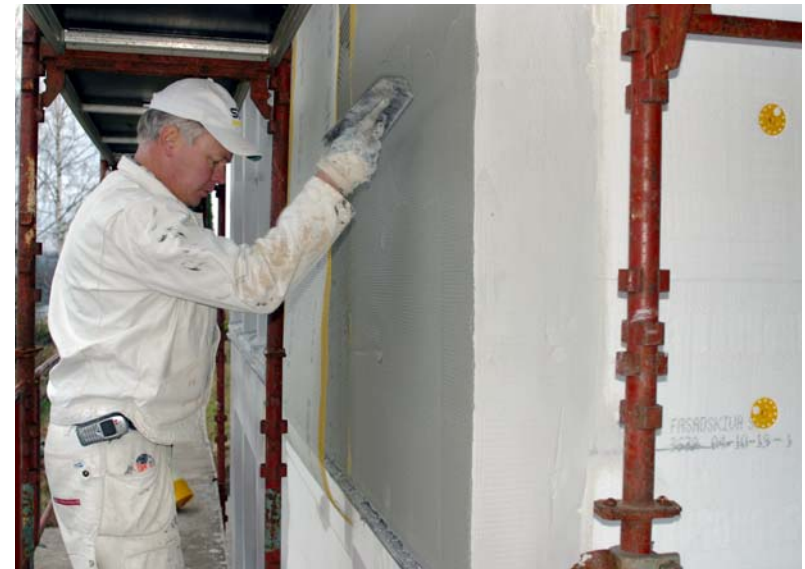
BILD 5.7 EPS-isolerad yttervägg. Fasaden skall putsas.
