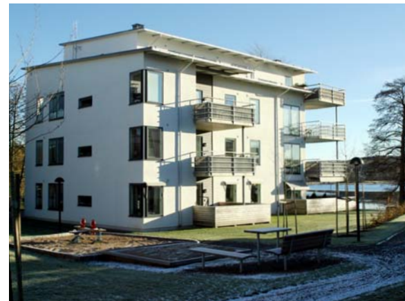
Bild 5.4 I Sverige finns en lång putstradition som kan bevaras även vid högisolerade ytterväggskonstruktioner.
